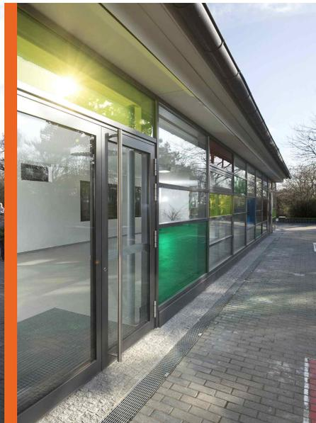
Eingang | Pfosten-Riegel-Fassade
